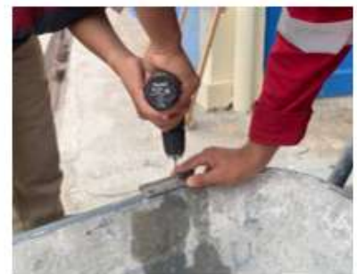
Rajah 4 : Menebuk lubang untuk meletakkan ensel.
